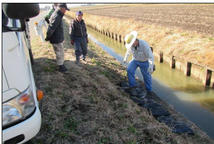
排水路法面の補修 (土嚢詰込み)
