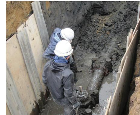
パイプライン漏水補修工事（2箇所）
