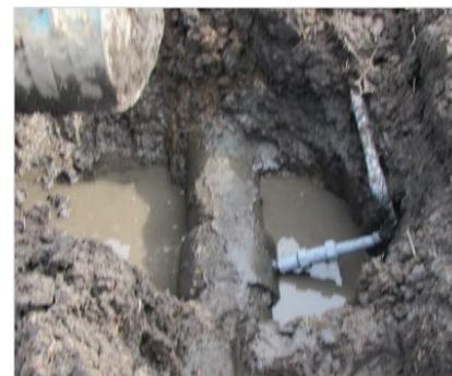
パイプラインの取水栓 漏水補修工事（3箇所）
