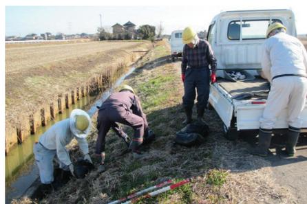
法面の陥没箇所へ土のうを裏込め補修（5箇所）
