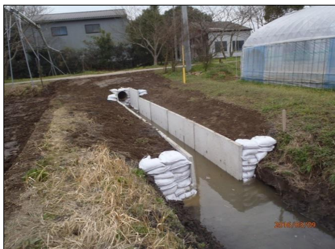
排水路法面崩壊対策工事
