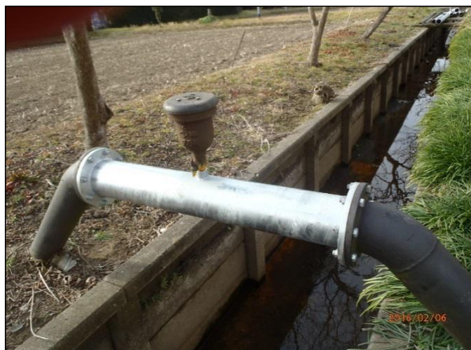
パイプライン修理 (水管橋)
