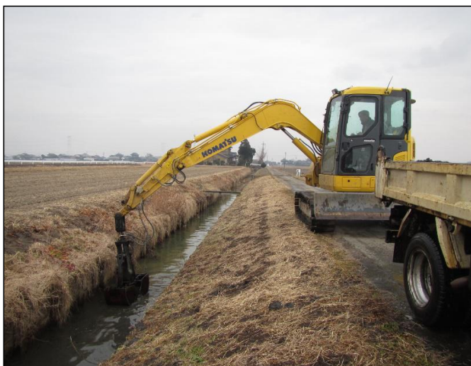
枝線排水路泥上げ工事
