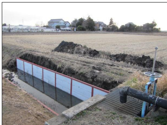
排水路法面崩壊対策(コンクリート柵渠板)敷設工事
