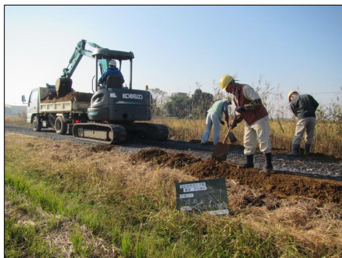
農道砕石舗装工事
