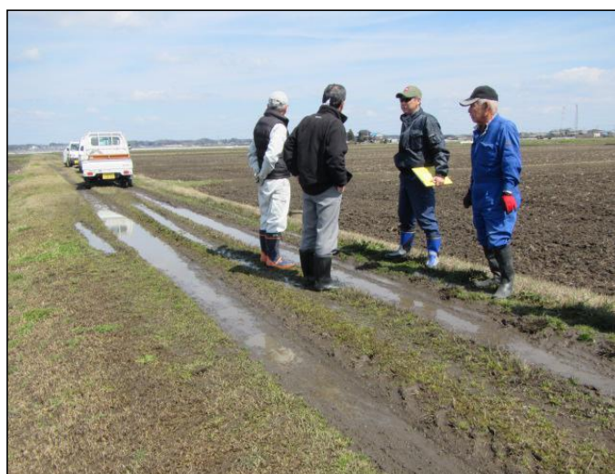
農道・水路の点検・機能診断
