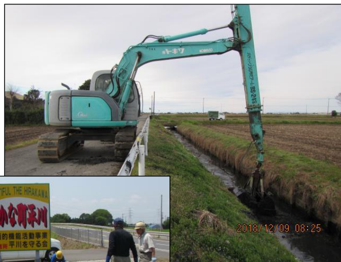
幹線排水路の泥上げ工事
