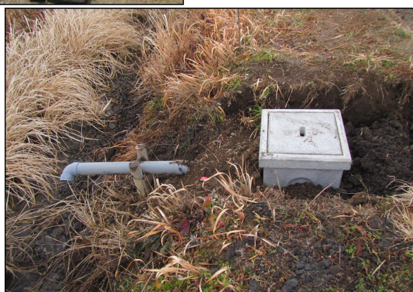
パイプライン泥吐き口移設工事
