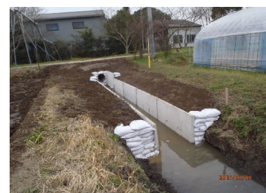
水路法面崩壊対策(長寿命化)
