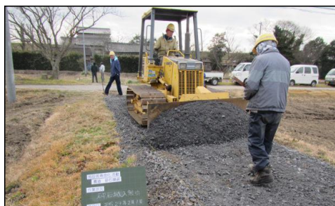
農道の砕石舗装
