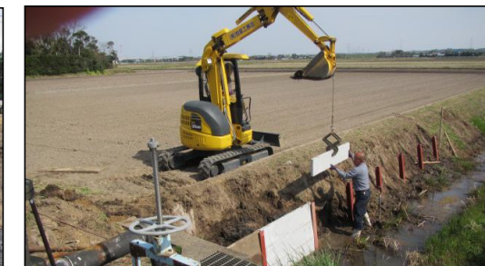
水路の柵渠更新
