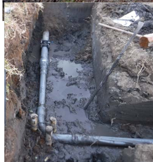
パイプライン泥吐き口移設工事
