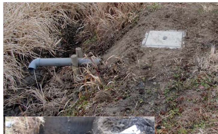
パイプライン泥吐き口移設工事
