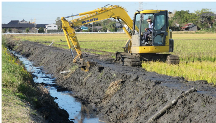
排水路の泥上げ工事
