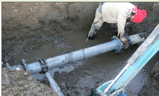
パイプライン修繕工事
