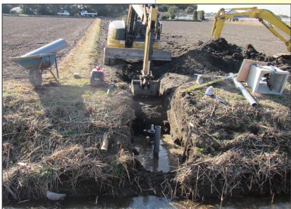
パイプライン泥吐口移設更新工事
