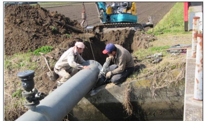
パイプラインパッキン更新工事 (Ø400 mm)
