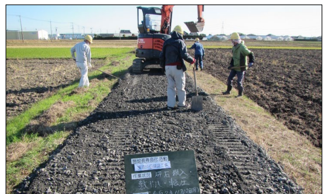
直営での農道砕石舗装工事 (L=398m)
