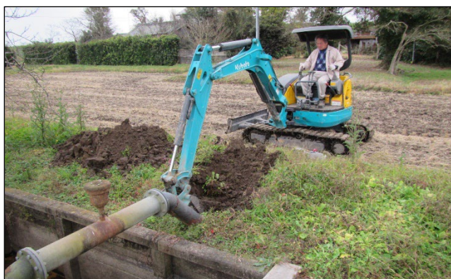
パイプラインフランジ更新工事 (Ø150 mm)
