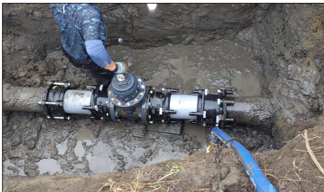
パイプライン仕切弁の更新工事 (Ø200 mm、2カ所)
