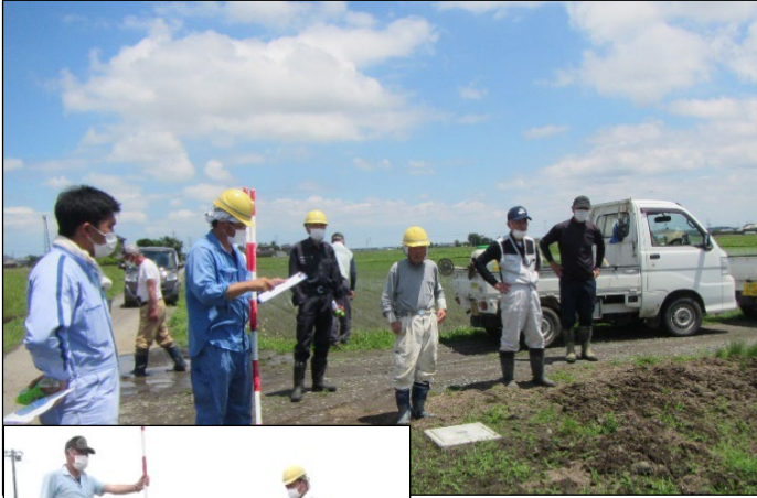
農道・水路等の点検、 機能診断と補修活動 (砕石敷均し)。
