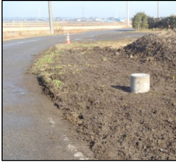
仕切弁の更新(その2)工事 →
