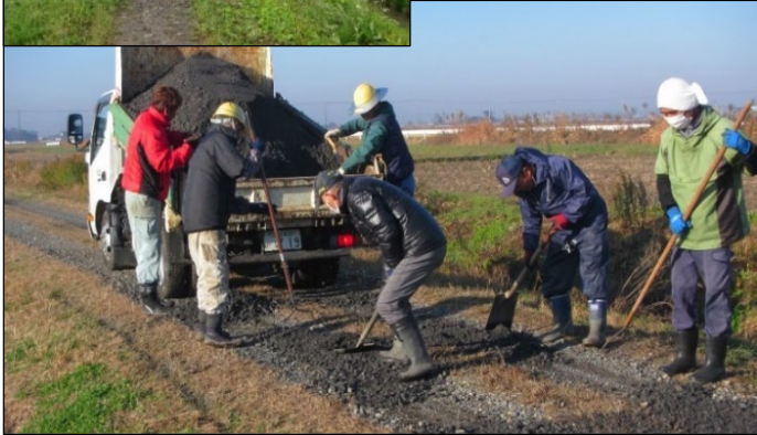
農道・水路等の点検、 機能診断と補修活動 (砕石敷均し)。
