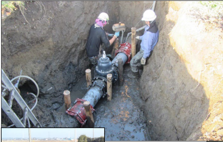
← 仕切弁の更新(その1)工事
