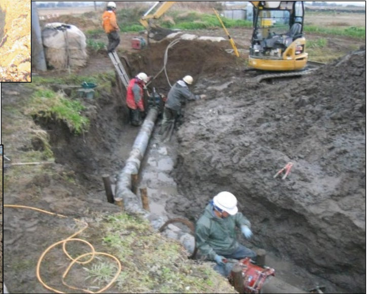
← 仕切弁の更新(その1)工事
