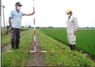
農道・水路等の点検、 機能診断と補修活動 (砕石敷均し)。
