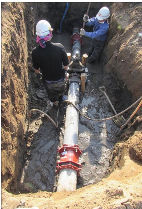
新しい仕切弁に替えました（口径 200 mm）
