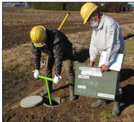
新しい仕切弁に替えました（口径 200 mm）
