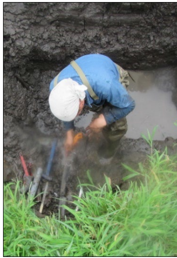
パイプラインの漏水補修
