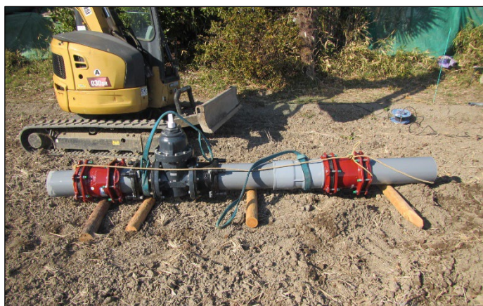
新しい仕切弁を設置しました（口径200mm）
