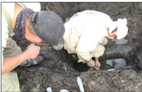
パイプライン給水栓取出漏水補修
