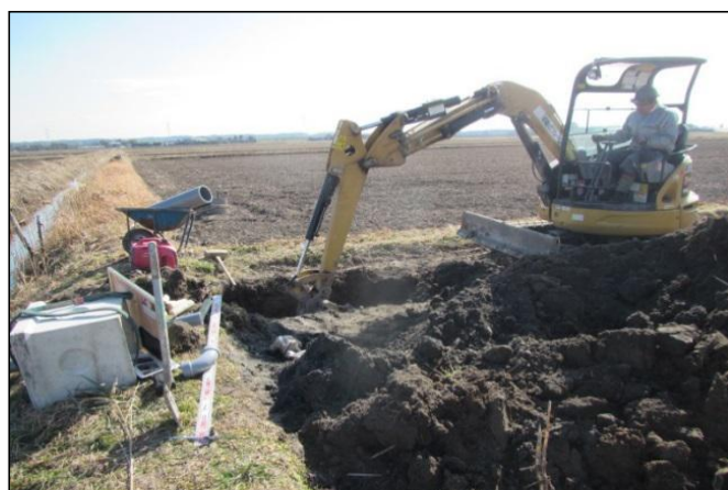
パイプライン泥吐き口移設工事
