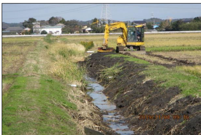
枝線排水路泥上げ工事
