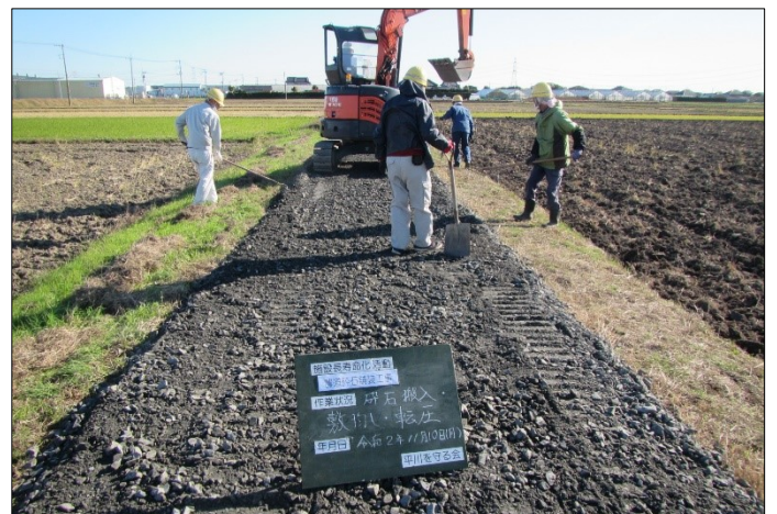
農道碎石舗装工事（自主活動）
